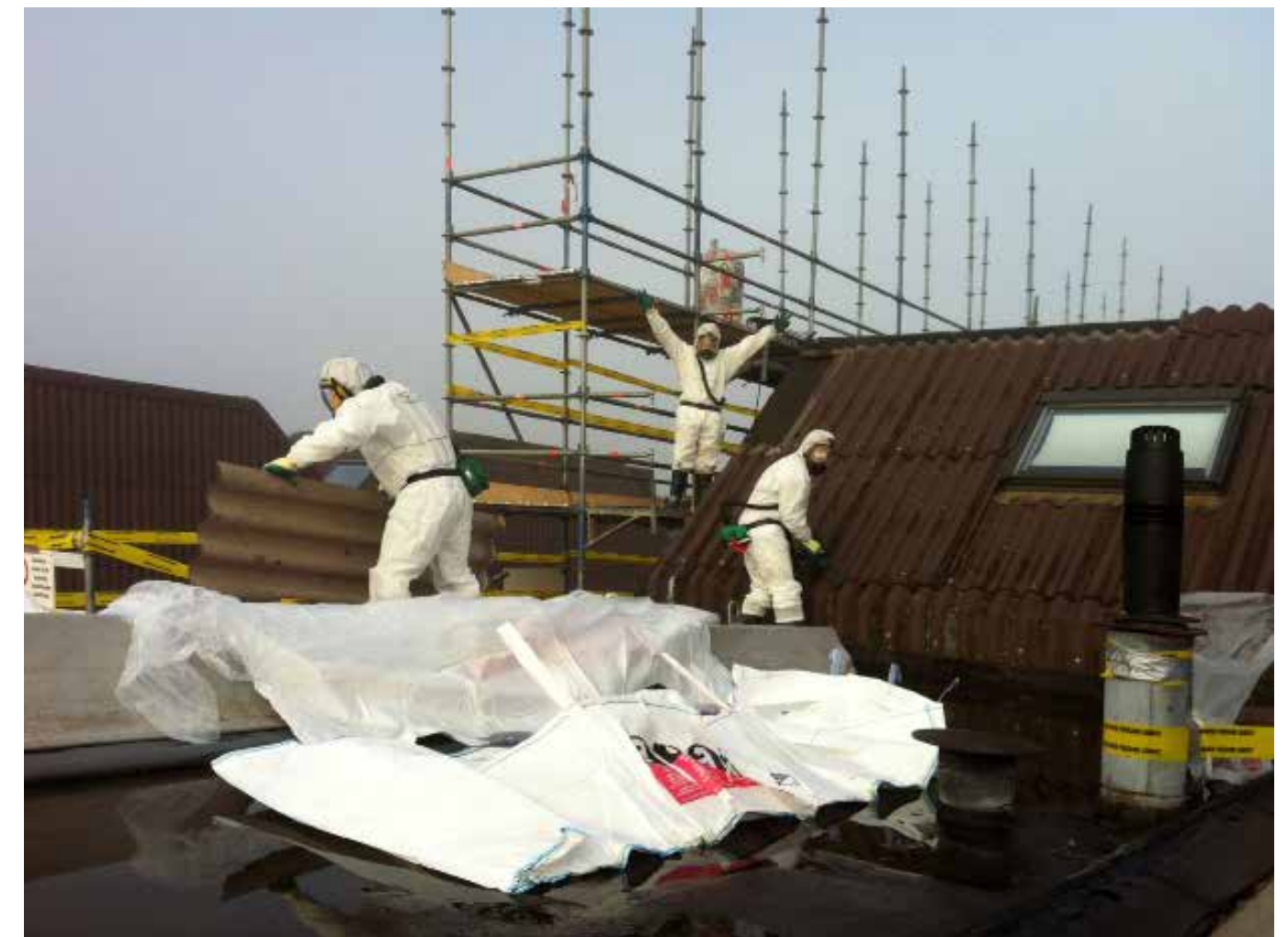
Er zijn vele partijen intensief bij de asbestsanering betrokken.'
